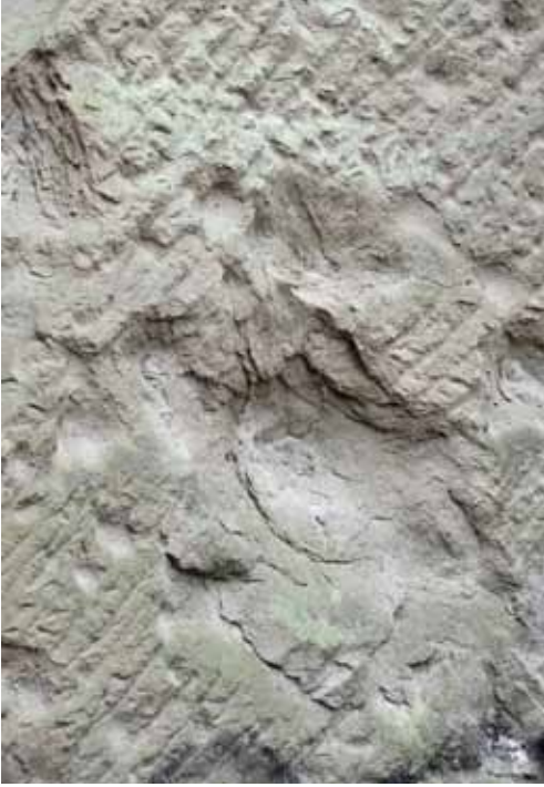
Abb. 25: Abschuppung und beginnende Sickerlochbildung im Schilfsandstein (Mittlerer Keuper). Diese Verwitterungsstrukturen haben sich an einer im Steinbruchbetrieb freigestellten Fläche im Laufe einiger Jahrzehnte entwickelt (die Werkzeugspuren sind an den von oben rechts nach unten links gerichteten Kratzspuren noch erkennbar). Die Verwitterungsformen in diesem fein-mittelkörnigen Sandstein sind dem Dolomit der Frankenalb in vieler Hinsicht ähnlich. – Aufgelassener Steinbruch beim Judenfriedhof Ullstadt, Steigerwald (GK25 Scheinfeld)
