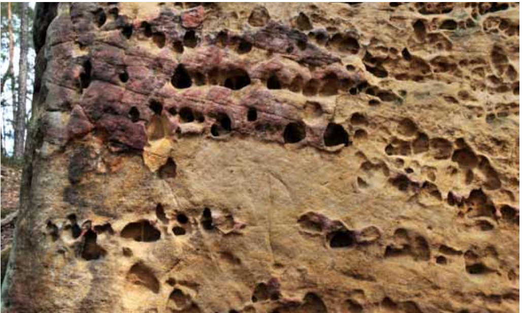
Abb. 31: Krustenbildung und Wabenverwitterung im Rhätolias-Sandstein. Die Kruste ist durch farbintensive Fe-Hydroxide abgehoben und teilweise von aktiver Wabenverwitterung durchlöchert (linkes Viertel oben), darunter ist die Kruste abgeplatzt und hat dabei auch völlig unstrukturierte, „frisch“ erscheinende Flächen hinterlassen. – Rhätolias-Sandstein, Ernst-Michel-Felsen südl. Gärtenroth (GK25 Kulmbach)
