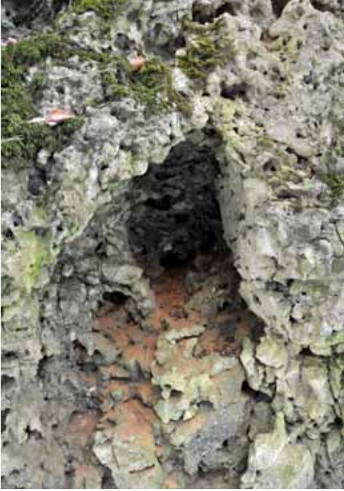
Abb. 29: Kavernöses bis pseudobrekziöses Gefüge mit Dolomitsand-Akkumulation. Spätstadium der Dolomitverwitterung mit Destabilisierung größerer Gesteinsbereiche. Diese Ansicht verdeutlicht, warum fortschreitende Lochverwitterung mit zunehmender Austrocknung und versiegenden Wasseraustritten verbunden ist: Die Zunahme an Makroporen und größeren Hohlräumen enthält keine horizontalen Sickerbarrieren mehr, die das Wasser zur Außenseite des Gesteins leiten könnten. – Wasserstein, entlang der Straße Höchstadt-Betzenstein, Oberes Kimmeridge (GK25 Betzenstein)
