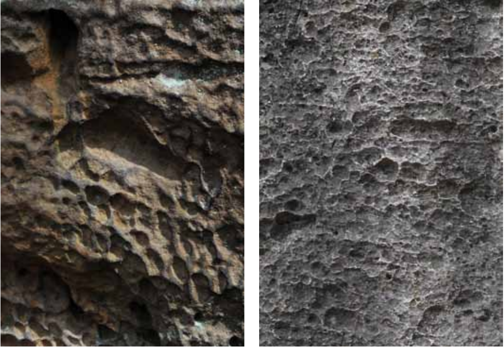
Abb. 15: Links: Wabenverwitterung im Sandstein: die Grate zwischen den Waben sind mit Limonit zementiert und krustenartig verhärtet, während sich in den Waben die zerstörende Auflockerung des Sandsteingefüges vollzieht (Rhätolias-Sandstein, Ernst-Michel-Felsen südl. Gärtenroth, GK25 Kulmbach). Rechts: Wabenverwitterung im Dolomit, überwiegend fossile Formen. An der Zementation der Grate ist hier sicher Calcit beteiligt; andere möglicherweise vorhandene Verbindungen waren mit den gegebenen Möglichkeiten nicht nachzuweisen. – Felsen am NE-Ausgang von Neuhaus (GK25 Hollfeld)
