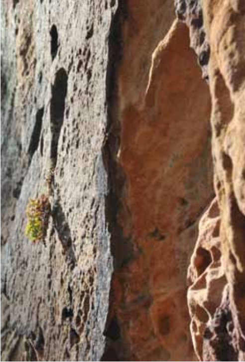
Abb. 32: Strukturdeckende Fe-Hydroxid-Kruste an einer Sandsteinwand. Hinter der zunehmend undurchlässiger gewordenen Kruste ist es bereits vor ihrer Ablösung zu Gesteinszersatz gekommen. Das kann offenbar so weit gehen, dass sich dort noch vor ihrem endgültigen Abplatzen Bereiche mit Loch- oder Wabenverwitterung entwickeln. – Rhätolias-Sandstein, Ernst-Michel-Felsen südl. Gärtenroth (GK25 Kulmbach)
