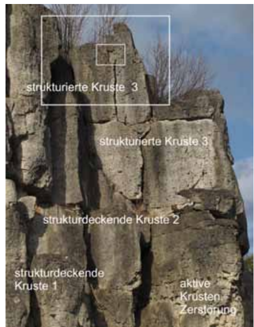
Abb. 34: Tafelbankiger Dolomit mit multiplen Krusten. Die für fränkische Dolomitfelsen ungewöhnlich kantigen Quader sind durch die von Krusten verursachte Stabilisierung der Oberflächen bedingt. Die Verkrustung hat offenbar sehr früh – vermutlich schon vor der Freistellung der Felswände – in Klüften eingesetzt. Hinter abgeplatzten Krusten sind in mehreren Lagen weitere Krusten angelegt. So ist hinter der Kruste 3 in einem ausgebrochenen Abschnitt bereits eine nächste zu sehen (kleines Rechteck im großen). – Lok. wie Abb. 33
