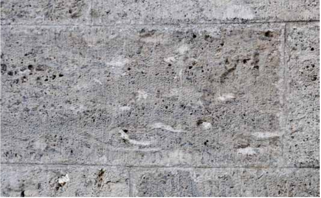
Abb. 6: Dolomit-Werksteinquader an der Kirche in Eichig. Deutlich unterscheidbar sind dichte, helle Bereiche (ehemalige Schwammgewebe) mit ebenfalls dichten, dunklen Rändern (ehemalige Thrombolithen-Fazies) – vgl. dazu Abb. 1-3. Die dazwischen gelegenen mittelgrauen Bereiche sind grob porös und zum Teil auch schon von beginnender Lochverwitterung erfasst. – Nördliche Frankenalb (GK25 Weismain)
