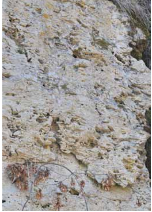
Abb. 36: Eine stark strukturierte Kruste, teilweise schon kavernös und zerstört, ist dabei, sich von der dahinter liegenden, relativ „frisch“ wirkenden Fläche abzulösen. – Lok. Obertrubach, wie Abb. 7, 8, 14
