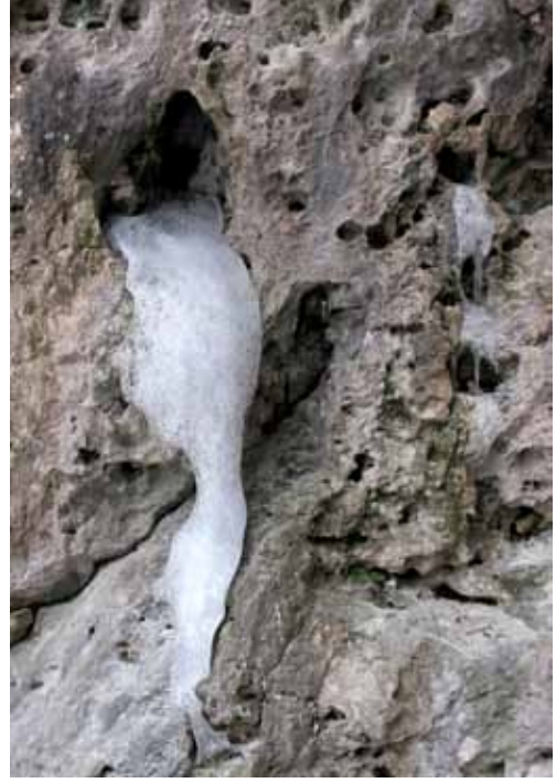
Abb. 26: Lochverwitterung zeigt im Gegensatz zur Sickerlochverwitterung keine Zurückverlegung der Umgebung, selbst wenn – wie hier durch Eiszapfen dokumentiert – episodischer Ausfluss erfolgt. Dies wird durch eine höhere Stabilität der Lochumgebung und/oder eine geringere Diffusion in der Umgebung des zum Loch laufenden Wassers erreicht. Die Lochrückwand kann hingegen weiter in den Fels zurückwandern. Tendenzial ist die Entwicklung der Lochverwitterung durch ein fortschreitendes Nachlassen des Sickerwasserabflusses gekennzeichnet. Einige Löcher zeigen auch hier im Hintergrund eine Aufteilung in mehrere kleinere Sickerlöcher (vgl. Abb. 16), andere haben offensichtlich keinen Ausfluss mehr. Dennoch ist eine Weitergestaltung der Löcher durch feuchte Rückräume und andere physikalische Effekte möglich. – Wasserstein bei Betzenstein, Oberes Kimmeridge (GK25 Betzenstein)
